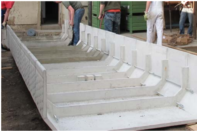
Bild 4: Aneinanderreihung von Regelsegmenten mit eingefädelt Spanngliedern
