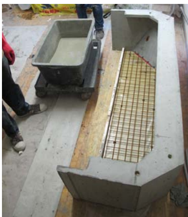
Bild 17: Betonieren des Querschotts am Lisenensegment
