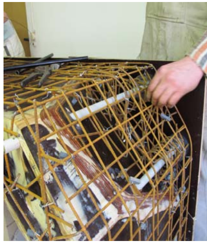
Bild 15: Zusatzbewehrung und Einbauteile an der Lisenensegmente
