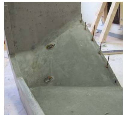
Bild 11: Lisenensegment mit Arbeitsfuge und Anschlussbewehrung für Querschott
