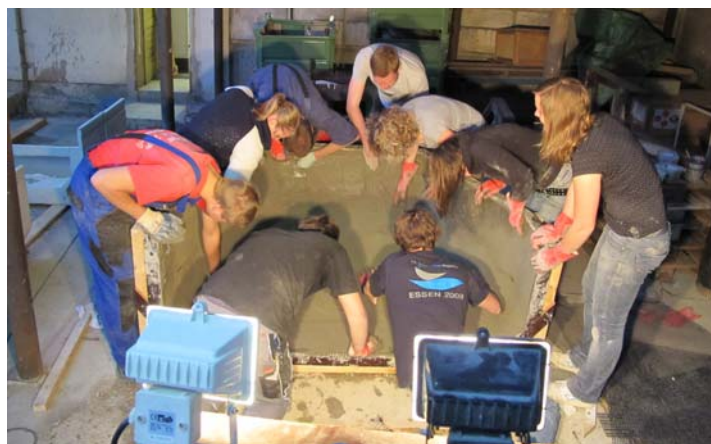
Bild 18: Betonieren des Bugteiles
