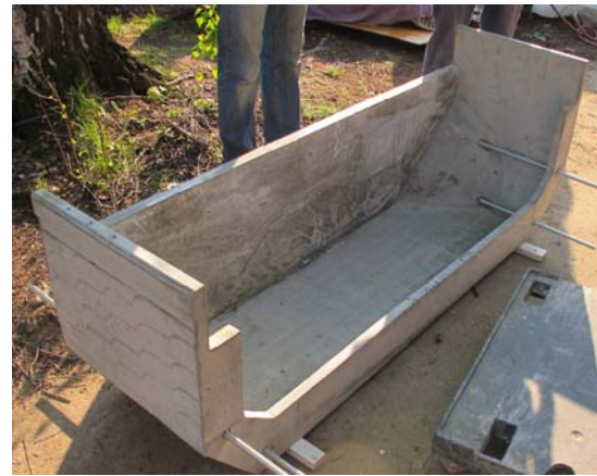
Bild 5: Lisenensegment mit eingefädelt Spanngliedern
