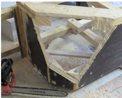
Bild 10: Umbau einer Regelsegmentform für die Lisenensegmente.
