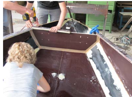
Bild 13: Umbau der Bugform zur Heckform
